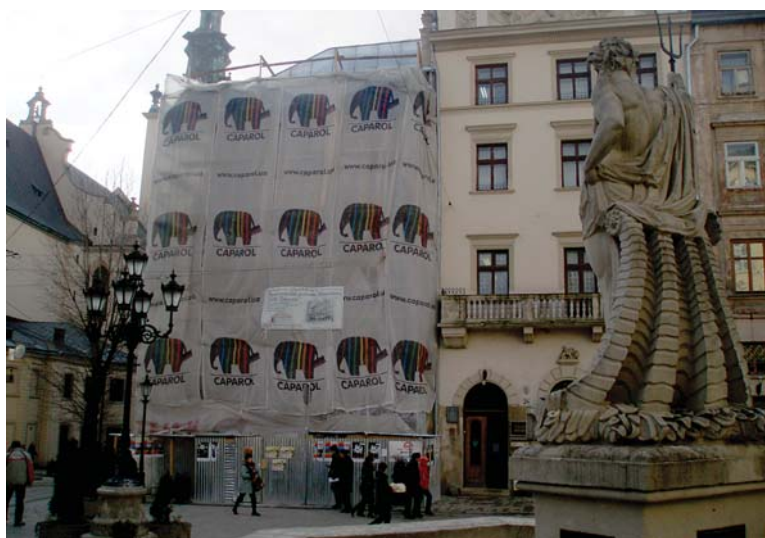
Kamienica Sholz-Wolfowiczów w trakcie renowacji
