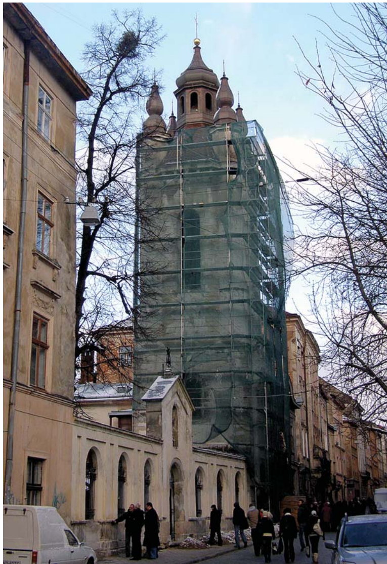
Trwa remont dzwonnicy katedry ormiańskiej
