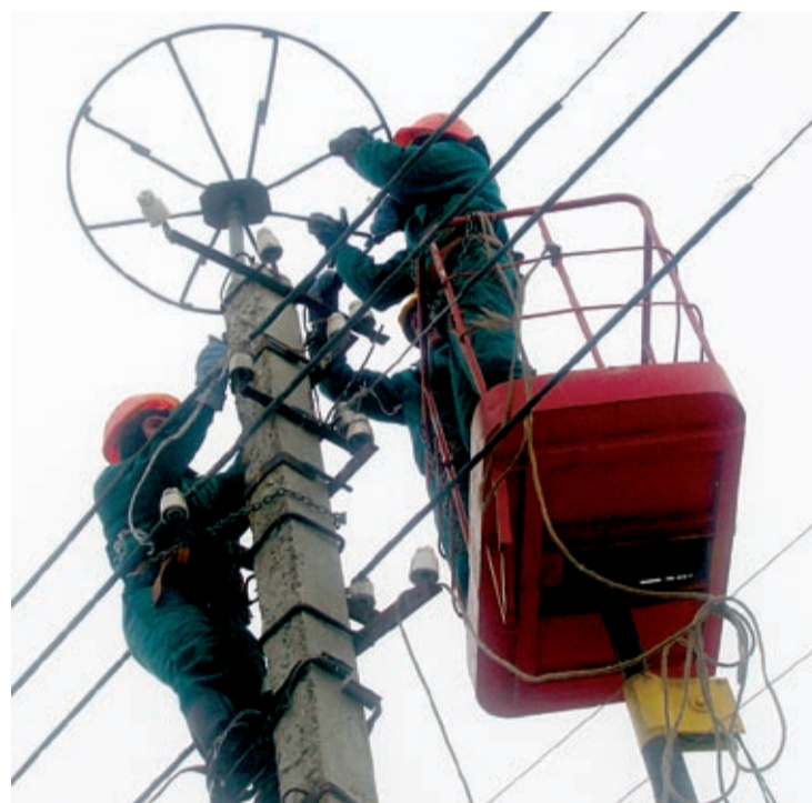
Energetycy montują ptakom nowe komfortowe gniazda
