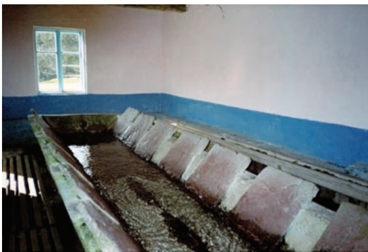
Woda ze źródła wpada bezpośrednio do koryta
