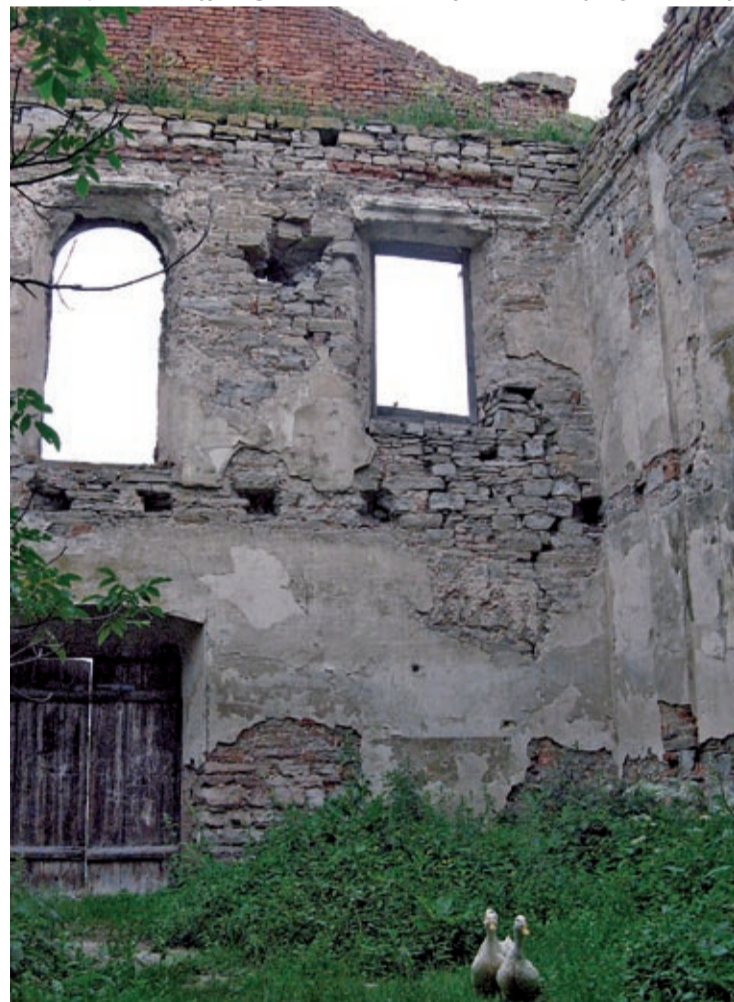
Ruiny kościoła przed remontem
