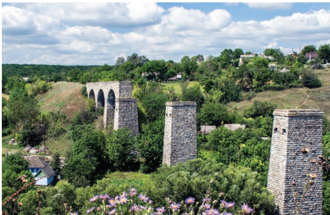
Nieukończony wiadukt nad Smotryczem, 1914–1917
