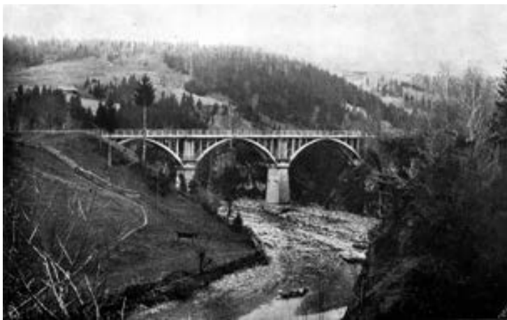
MOST NA RYBNICY NA DRODZE „KOSÓW – JASIONÓW GÓRNY”
