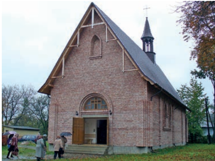
KOSÓW, KOŚCIÓŁ PARAFIALNY W TRAKCIE BUDOWY W 2008 R.
