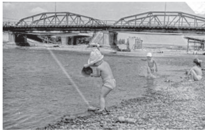
STARY MOST NAD BYSTRZYCA SOŁOTWIŃSKĄ. W GŁĘBI WIDAĆ BUDOWĘ NOWEGO MOSTU. POCZĄTEK LAT 70. XX W.
