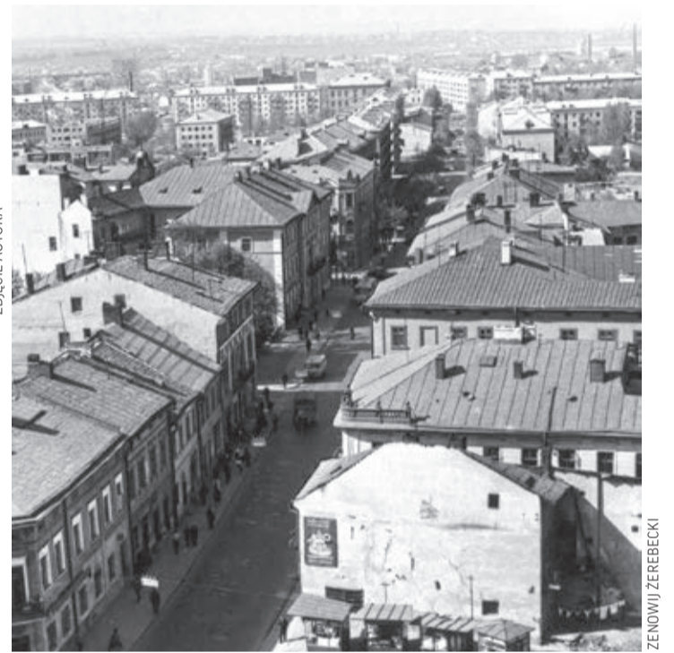
PANORAMA UL. HALICKIEJ. AUTOBUS JEST ZAPARKOWANY PRZED BUDYNKIEM, KTÓRY WKRÓTCE SIĘ ZAWALI
